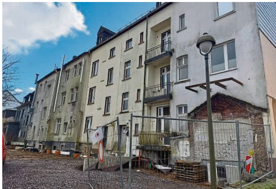
Hinter den Häusern wurde das Entwässerungssystem erneuert.
