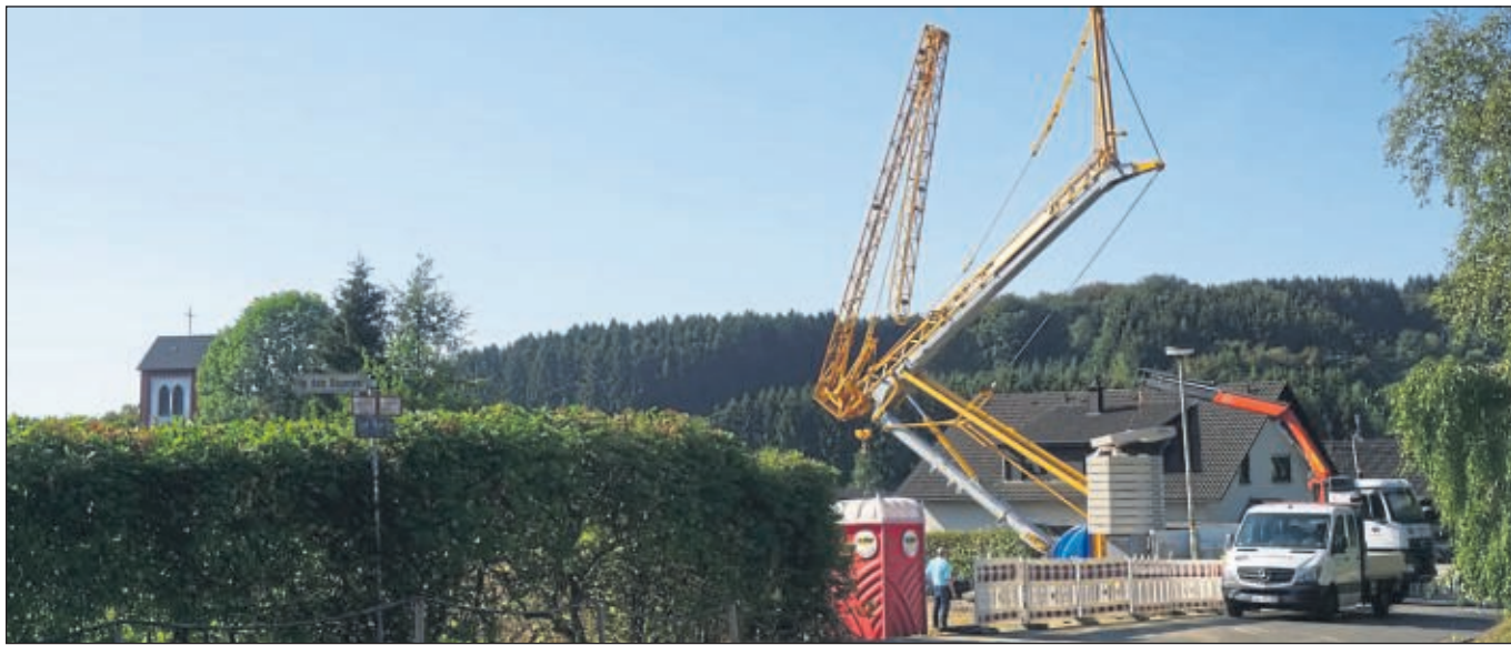
In „Pastors-Garten“ In den Bäumen an der Ebbestraße 4 liegt das Grundstück für den geplanten Komplex mit Eigentumswohnungen. Der Baukran steht seit Ende letzter Woche. Mitte Juni 2019 soll das Haus bezugsfertig sein. ■ Foto: Helmecke
