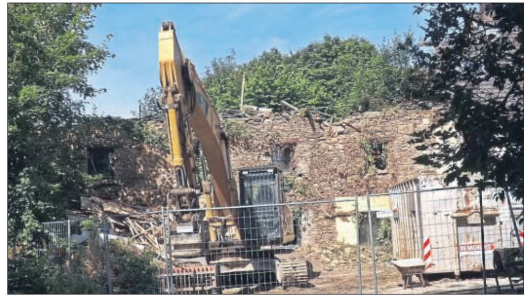
Auch das freigeräumte Grundstück der ehemaligen Valberter Herberge wird in Kürze bebaut. Hier sollen zwölf Mietwohnungen entstehen. ■ Archivfoto: Helmecke
