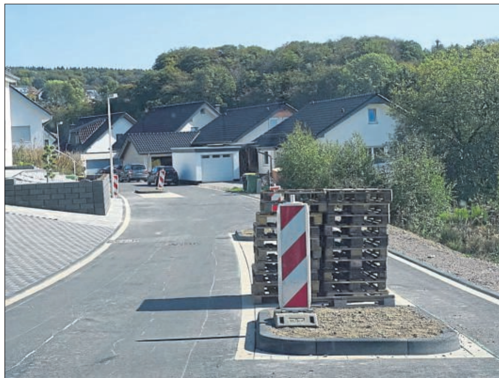
Der Endausbau im Karlsbader Weg ist bis auf die Straßenleuchten erledigt. Nicht alltäglich ist indes die Gestaltung der Straßen. Wie üblich bei Tempo-30-Zonen, handelt es sich zwar um eine Mischfläche. Hier deutet sich jedoch eine seltene Anordnung von Parkflächen nicht unmittelbar am Straßenrand an.
