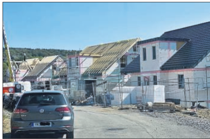
Am Reichenberger Weg entstehen die neuen Eigenheime quasi wie am Fließband. ■ Fotos: Helmecke
