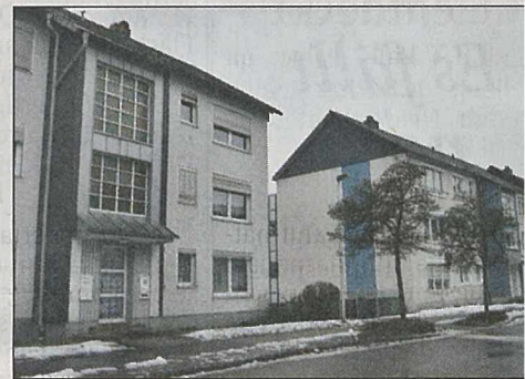
An der Dränkerkampstraße werden weitere Gebäude energetisch saniert.
